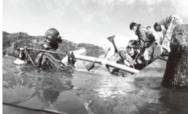
水中のがれき撤去の様子
